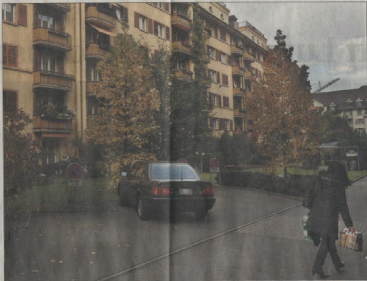
Die ABL-Siedlung im Gebiet Heimatweg/Claridenstrasse wird abgerissen, weil sie schief steht.
