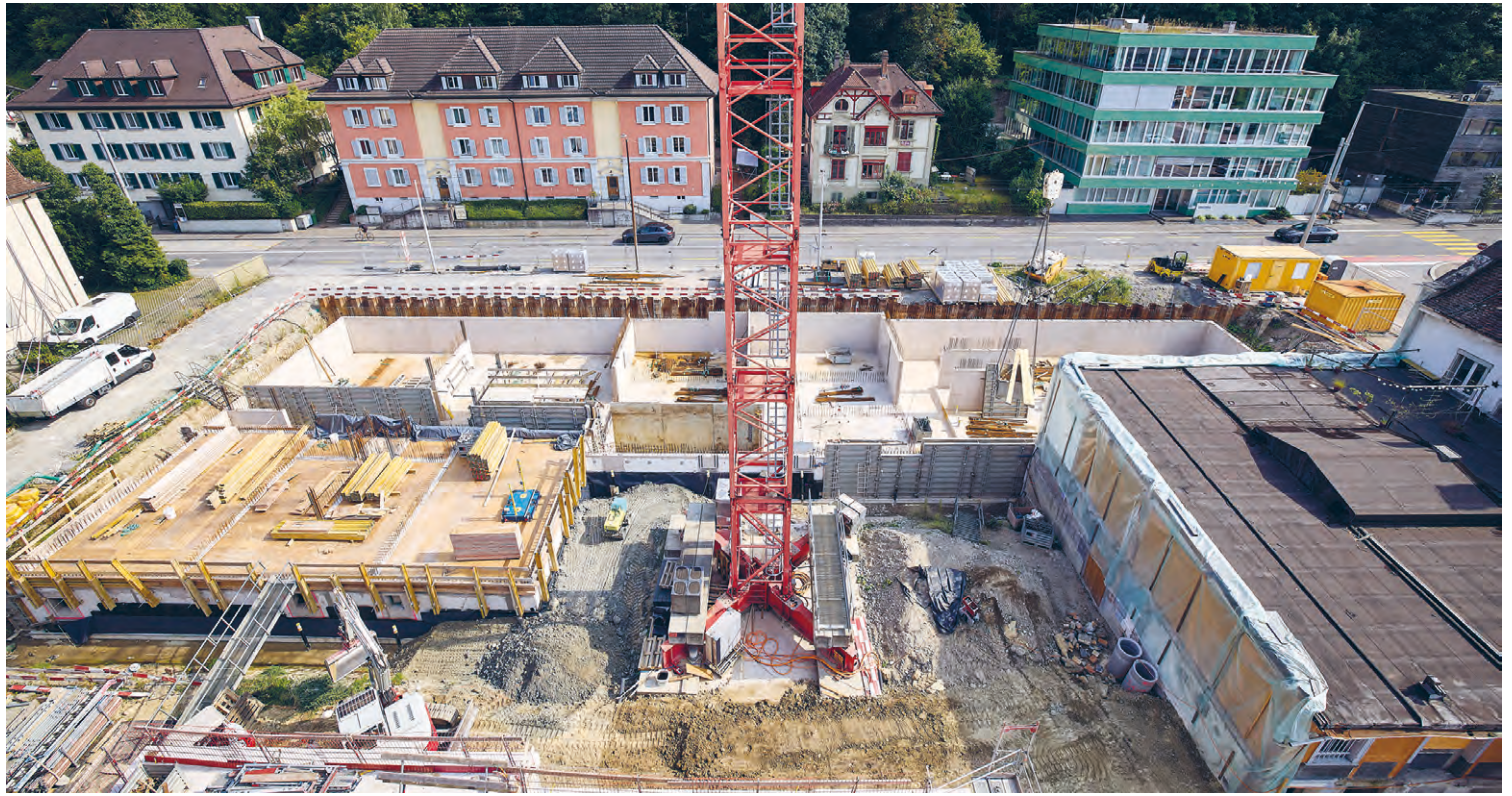
Inzwischen sind bei den abl-Häusern am Geissensteinring die Erdgeschosse bereits gebaut.
