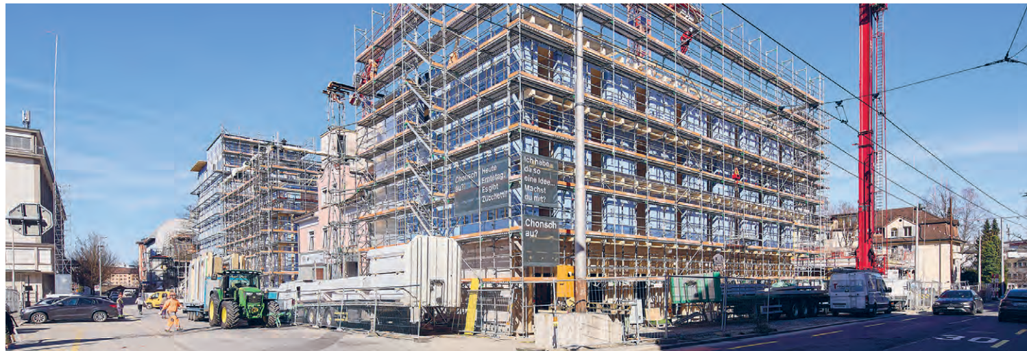
Das abl-Gebäude an der Industriestrasse 17 – vielleicht schon bald der Ort für Ihre Gewerbeidee?
