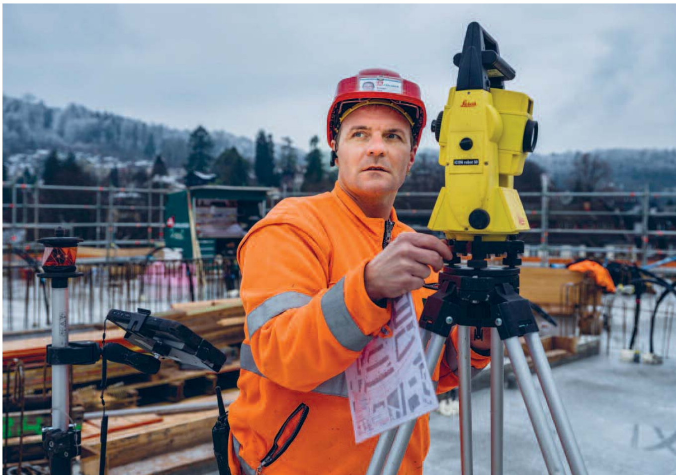
Mit Blick auf das Gesamte: Polier Jörg Elmiger am Vermessungsgerät.
