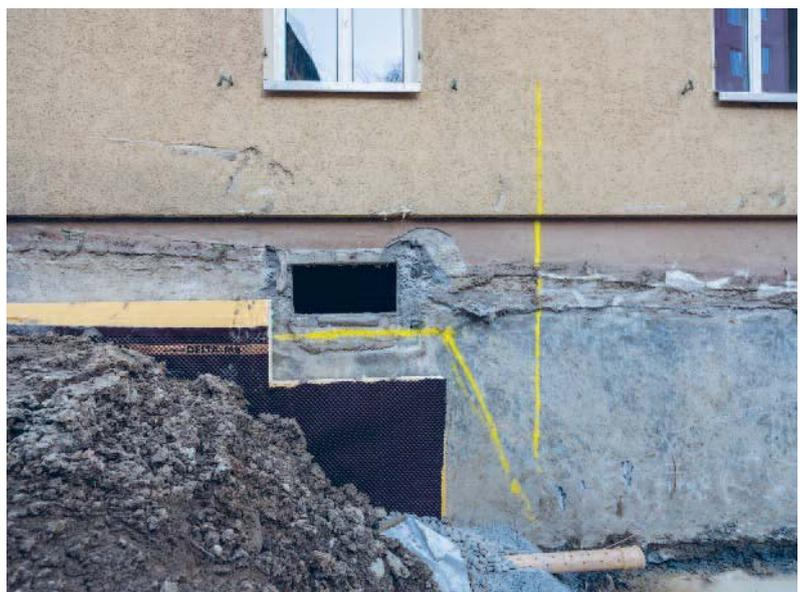
*Die Kellergeschosse sind freigelegt, teilweise schon isoliert und mit Sickerleitungen versehen. Der Weg für die energetische Sanierung ist quasi geebnet.*
