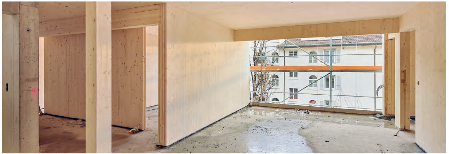
Rohbau-Einblick in eine Wohnung am Geissensteinring – mit Sichtholzwänden und -decken.
