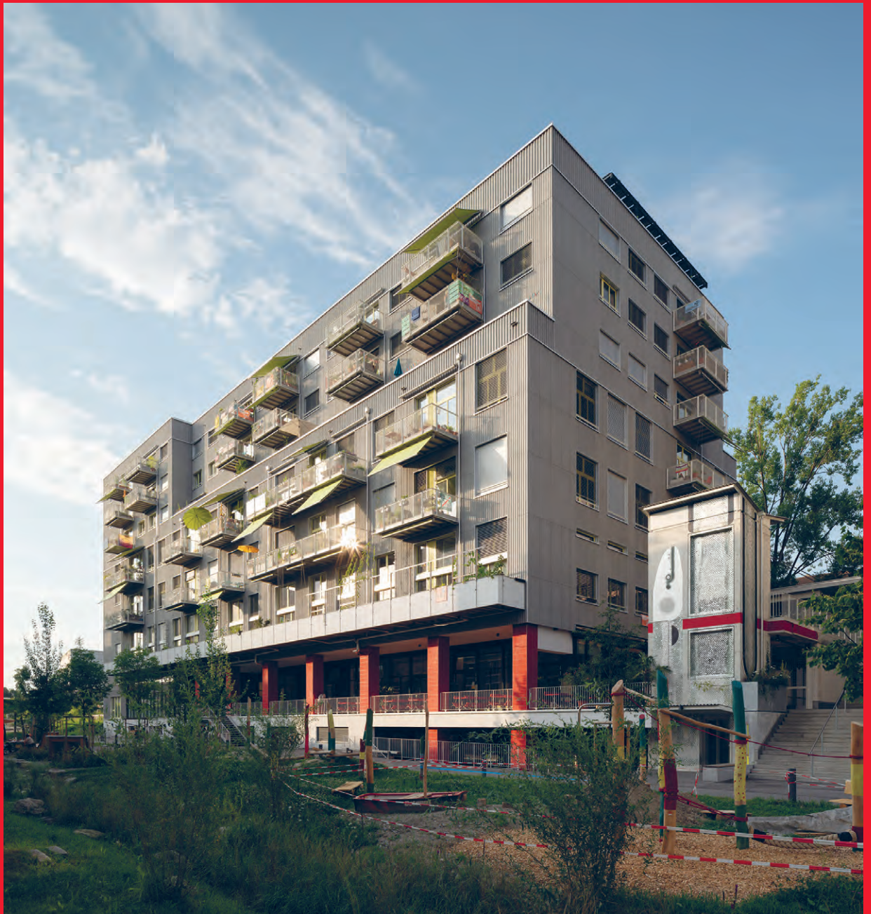
Der Holligerhof 8 entstand aus der Umnutzung des ehemaligen Lagerhauses von Chocolat Tobler.
